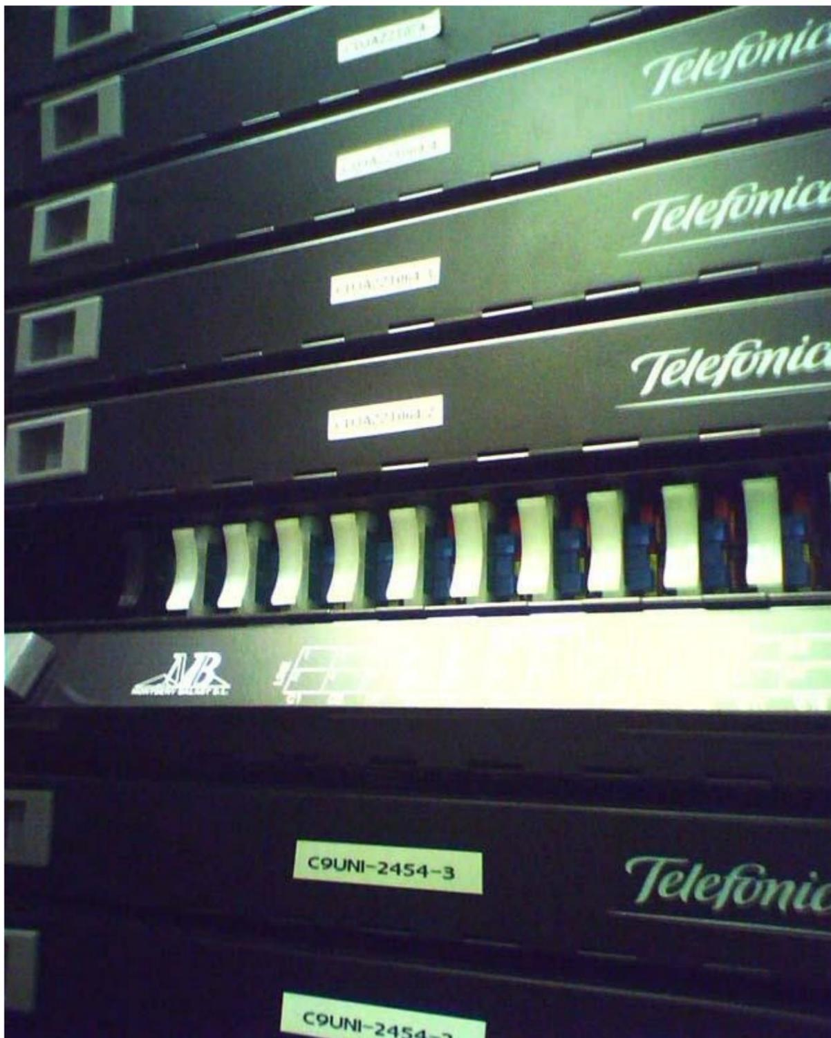
En las imágenes se observa el armario de filtros para Circuitos Compartidos, las bandejas que contienen los splitters y abriendo la tapa frontal de estas bandejas se observan las tarjetas de splitters, que se pueden sacar para poder facilitar su sustitución.
