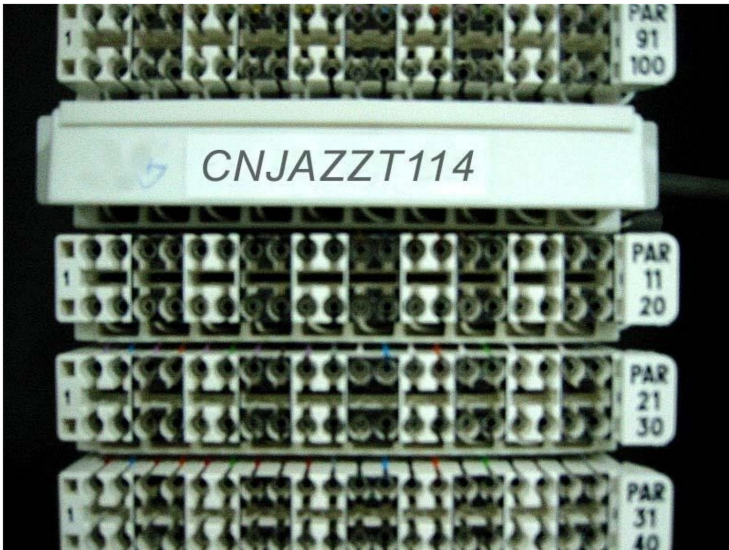
Desde este Espejo de Oba sale un cable rígido directo sin sub-repartidores hasta el armario de filtros, todos los cables rígidos desde las Salas que existen en las Centrales de Tesa, van directos y es normativa, no pueden existir puntos intermedios. Este cable rígido pareado por código de colores va por unas bandejas hasta el armario de filtros
