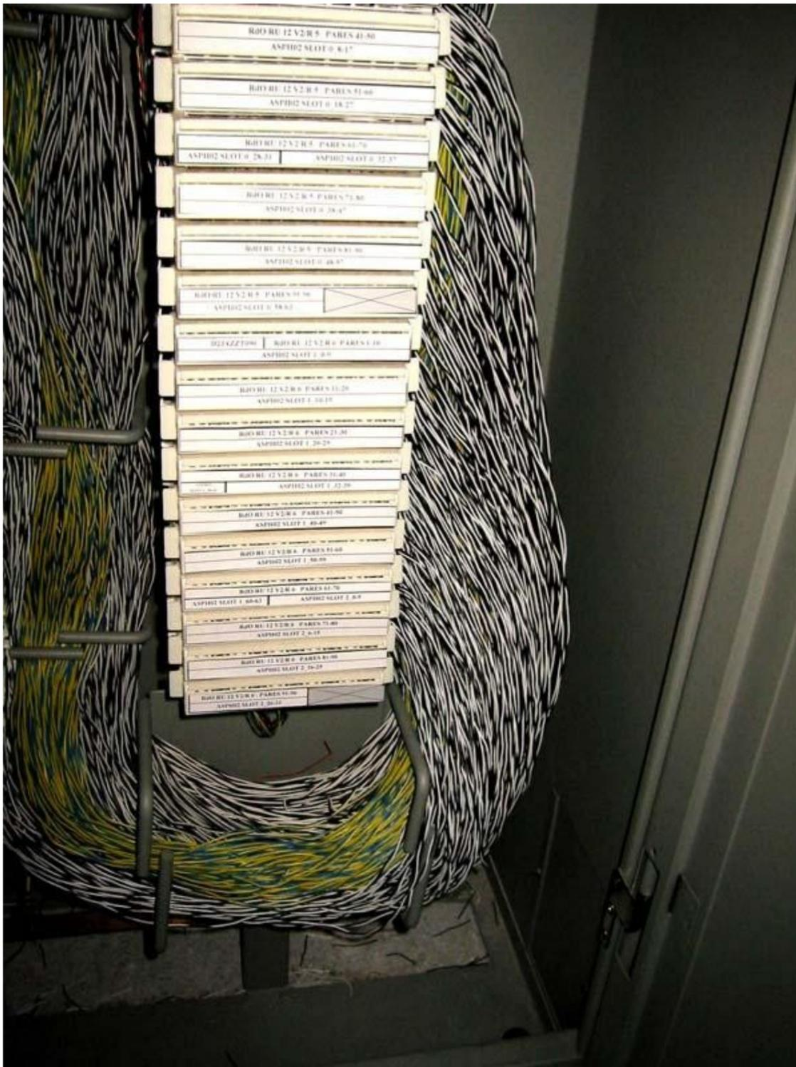
Así tenemos el recorrido desde equipo a través del cable rígido hasta Slot y de Slot a Espejo de Oba con un puente de cable de cobre parafinado, Azul/Amarillo, si es para circuitos de SHDSL o Compartidos (Datos) y Blanco/Negro si es para circuitos Desagregados, (con "tono"), Blanco/Negro estándar de TESA para indicar que tiene circuito de voz y Azul/amarillo estándar para indicar que es circuito de datos.
