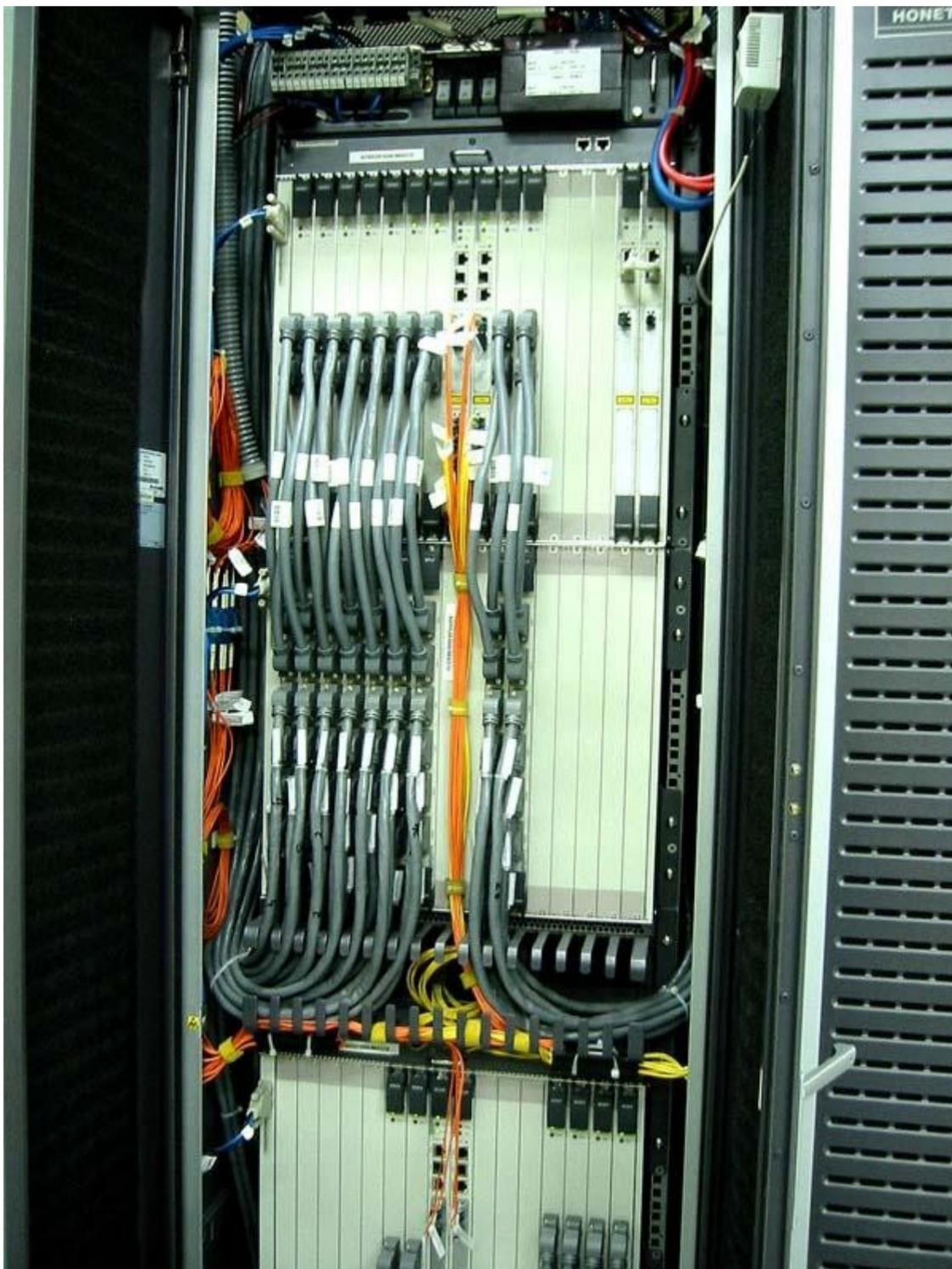
Estos cableados rígidos que van a los bloques Slot parten desde los equipos Huawei por conectores. Y dentro del Armario, Slot y Espejo de Oba van unidos por "puentes".
