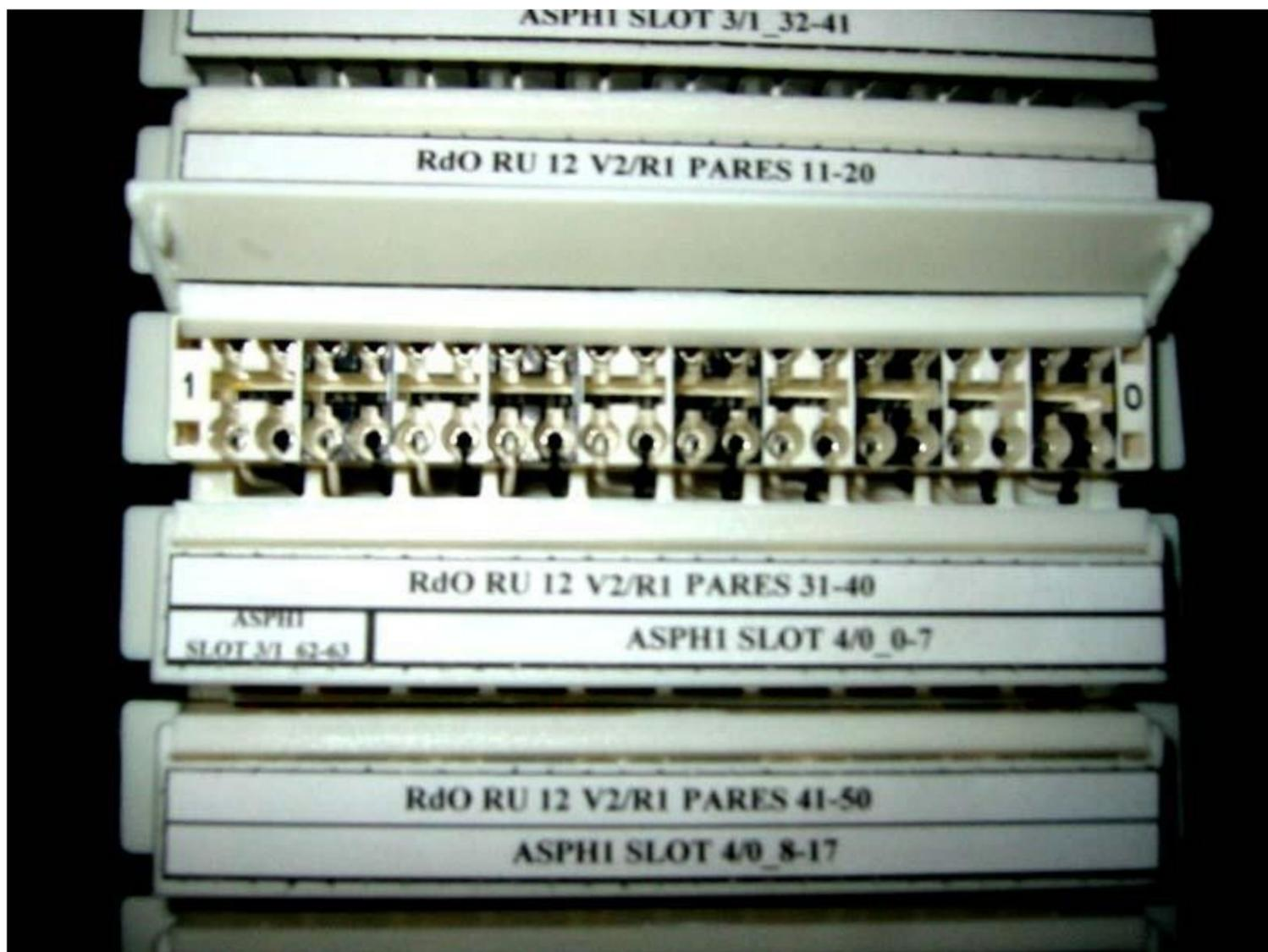
En la foto del Slot se observa una ranura intermedia, (todas las regletas tienen), que es donde se inserta la pichucha para aislar y realizar las comprobaciones.
