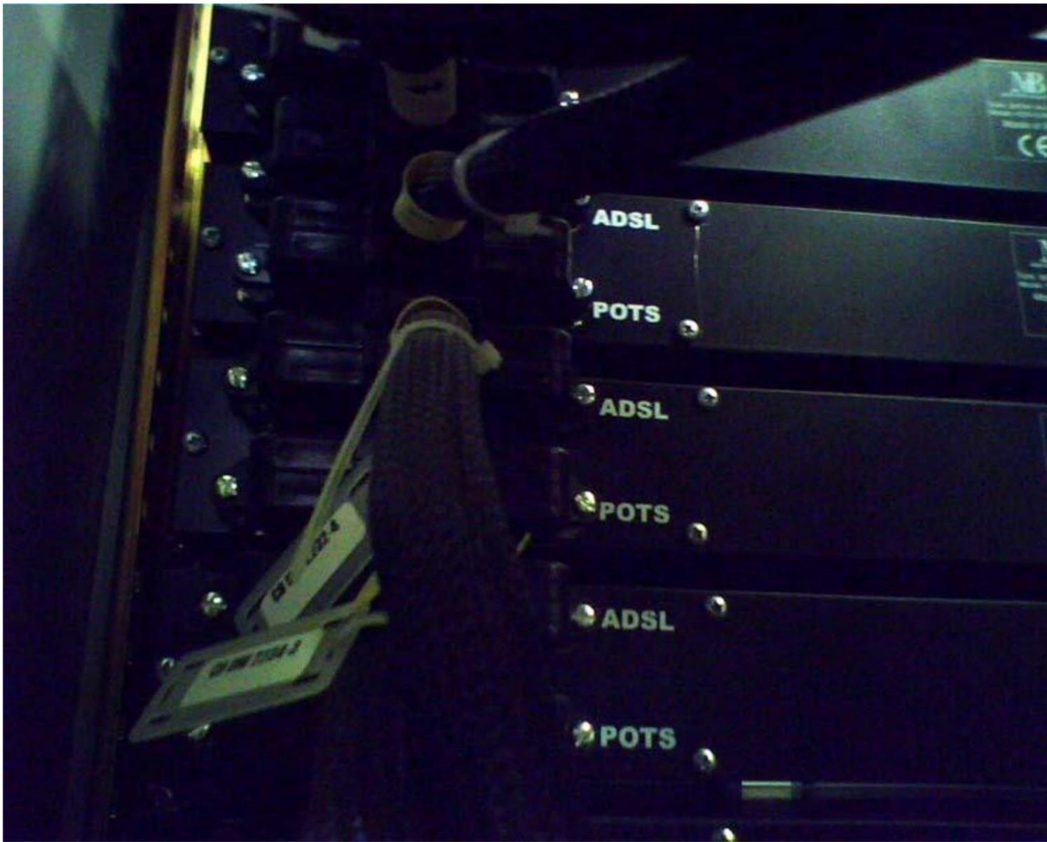
En este caso particular de Circuito Compartido tenemos un cable rígido directamente desde el bloque CNJAZZT114 ubicado en la Sala de Oba hasta la bandeja que corresponda en el armario, donde se conecta en la parte posterior en la posición ADSL y los POTS es el cable rígido que viene desde el R.U. del bloque donde los Celadores de Tesa conectan la línea de voz CNJAZZT112.
