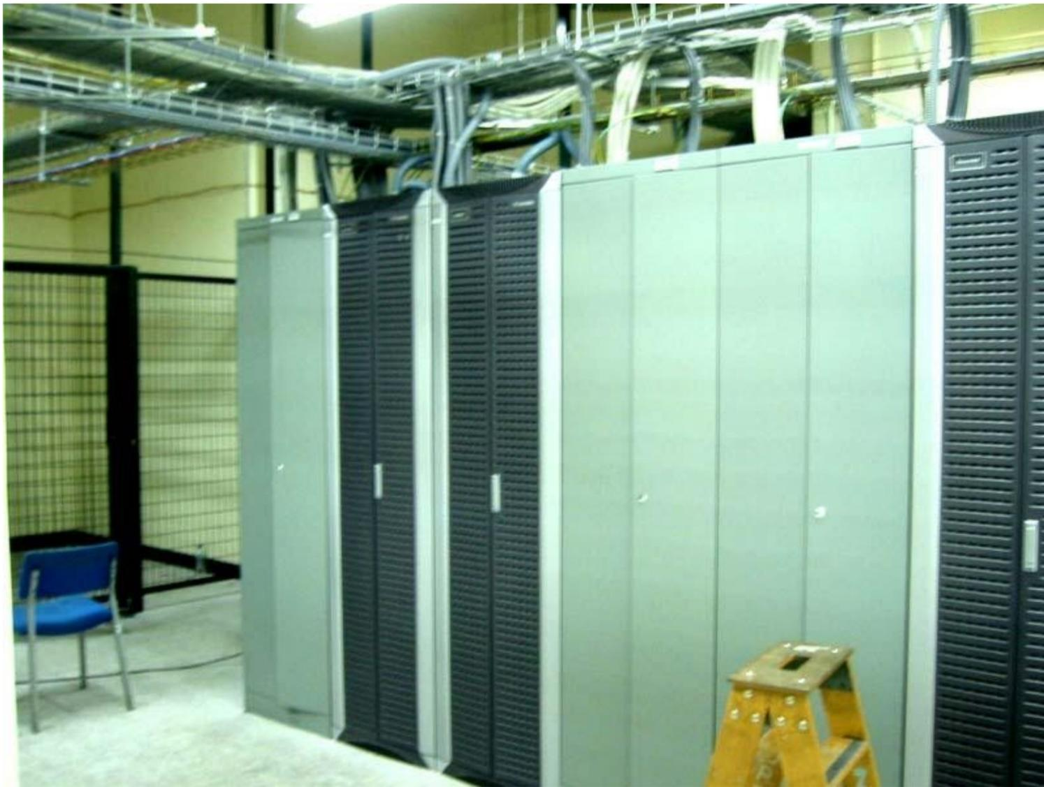
En la foto se pueden observar los equipos Huawei, (puertas oscuras) junto a los armarios de Slot-Espejo. Desde los Huawei salen cableados rígidos que van a los armarios (hacia los bloques Slot), y de aquí al Repartidor Urbano o a los Armarios de filtros para circuitos compartidos, los rígidos van directos y no existen subrepartidores.
